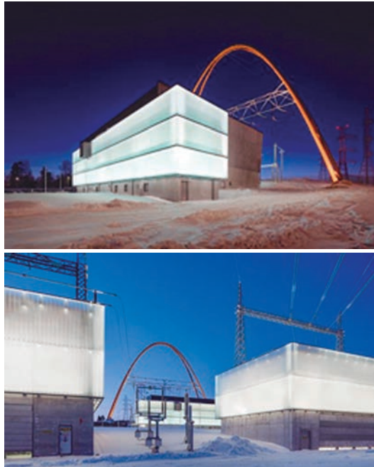
FIGURA 5.4. FINGRID FUE GANADORA EN EL FESTIVAL MUNDIAL DE ARQUITECTURA 2018, REALIZADO EN AMSTERDAM, NETHERLANDS, CON EL DISEÑO DE SU SUBESTACIÓN ELÉCTRICA LÄNSISALMI
